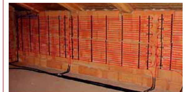
Esempio di installazione di pannelli radianti a parete.
