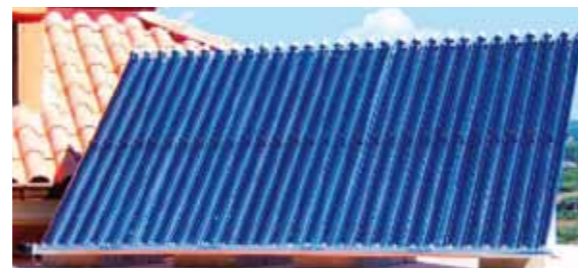
Esempio di pannello solare sottovuoto.
