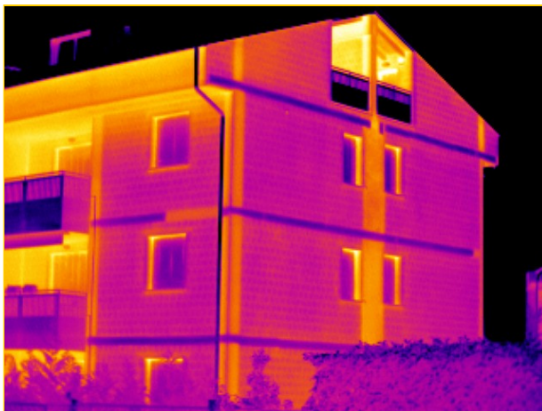
Orditura delle superfici di tamponamento e ponti termici sulle strutture portanti
